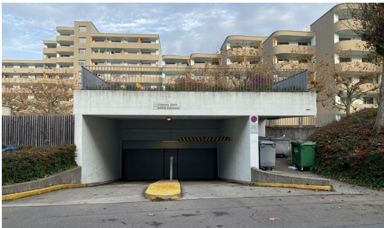
Abbildung 31: Aussenansicht Tiefgarage Heuried, Zürich (Bild: Stefan Gasser)
