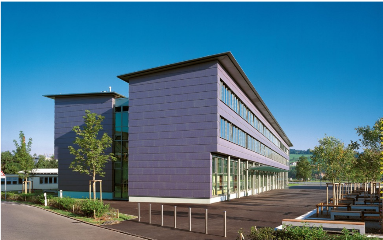
Abbildung 26: Aussenansicht Schulhaus Sennweid, Baar (Bild: archetage ag)
