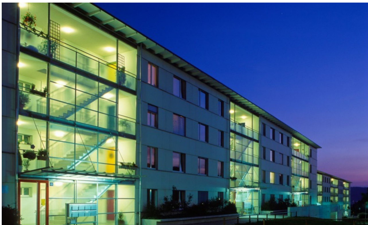
Abbildung 14: Aussenansicht Wohnsiedlung Rütihof, Zürich-Höngg (Bild ASIG)
