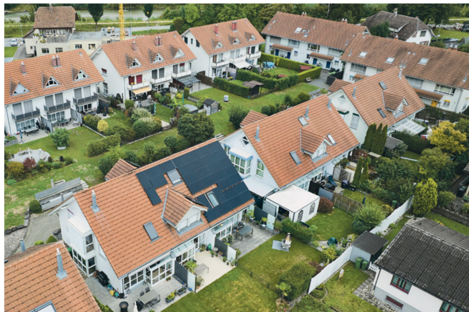
Dans le lotissement de maisons mitoyennes chauffées au gaz, on repère aussitôt la maison des Lohberger. Son voisin lui a loué une partie de sa toiture pour l'installation photovoltaïque.
