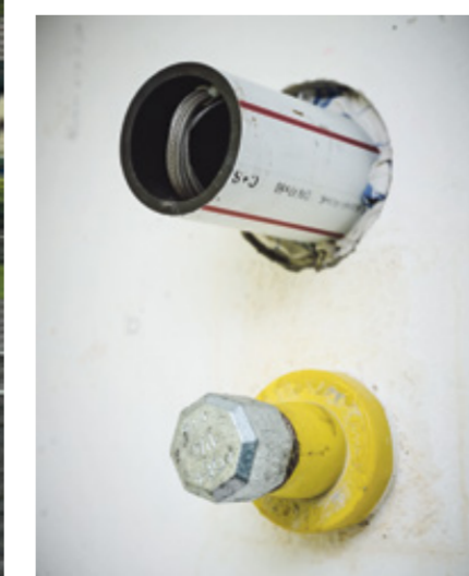
Der stillgelegte Gasanschluss (unten) und die vorbereitete Zuleitung für die E-Ladestation.
