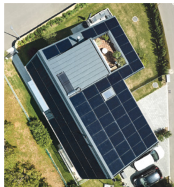
Das Dach ist mit Photovoltaikzellen und einer thermischen Solaranlage bestückt.
