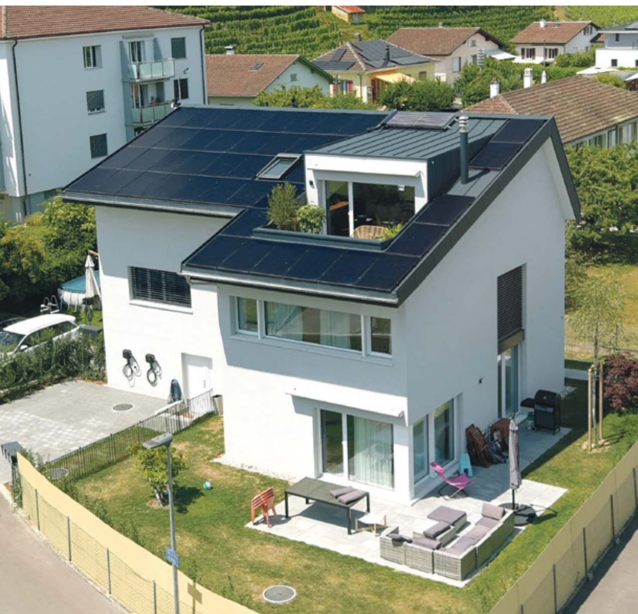
Auffallend am Haus von Raphaël Domjan ist seine asymmetrische Dachform, die eine optimale Anordnung der Solarmodule ermöglichte.
