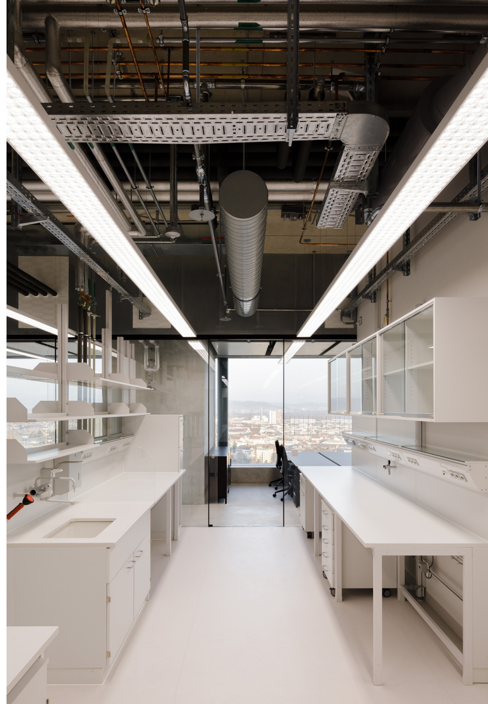
Abb. 11: Mit dem Einsatz von linearen Profilleuchten mit einer Abdeckung bestehend aus multiplen Linsen wird ein druckvolles und gleichzeitig blendfreies Licht in den Laborräumen ermöglicht, um eine adäquate Arbeitsatmosphäre zu schaffen.
