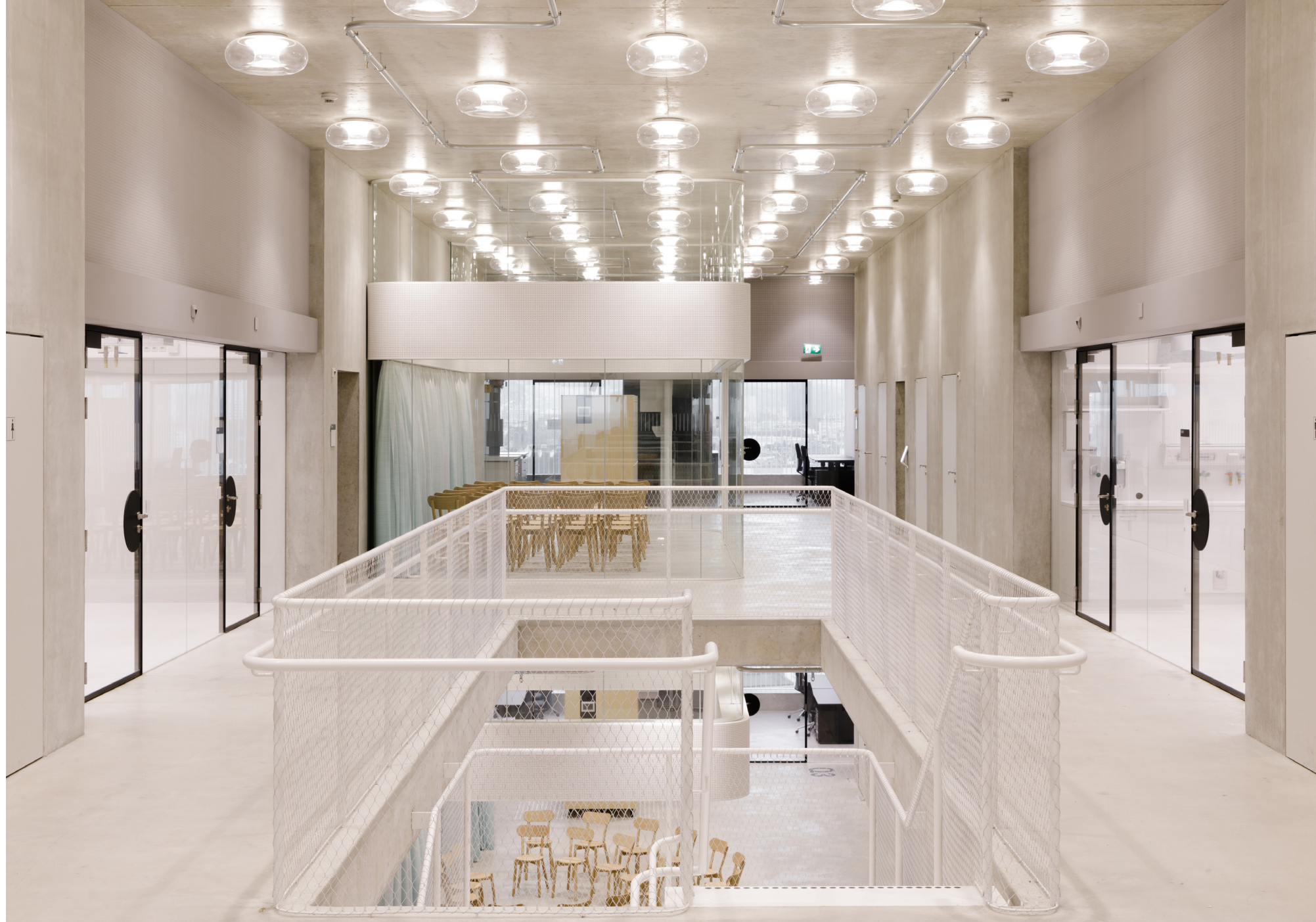
Abb. 9: Durch die flexible Schaltung der diffusen und direktstrahlenden Leuchtenkomponenten, können unterschiedliche Stimmungen geschaffen werden und die Beleuchtung an die individuellen Bedarfe verschiedener Nutzer oder Anlässe angepasst werden. Konzentrierte Einzelarbeit wird genauso ermöglicht wie Gruppenbesprechungen und soziales Beisammensein.
