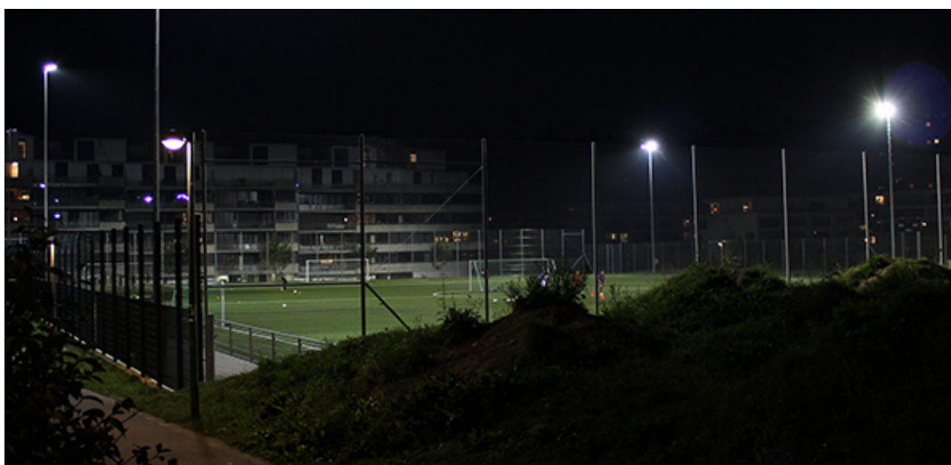
Figure 13 : Dans la perspective d'une utilisation plus dense du territoire, les nouvelles installations sportives sont construites si possible dans l'espace déjà bâti ou à proximité de celui-ci. De nouveaux bâtiments résidentiels sont aussi édifiés à côté de terrains de sport existants. Pour utiliser ces derniers de manière plus intensive et plus longtemps dans l'année, on les équipe souvent de gazon artificiel et d'un système d'éclairage, qui peut provoquer d'importantes immissions lumineuses dans le voisinage.
